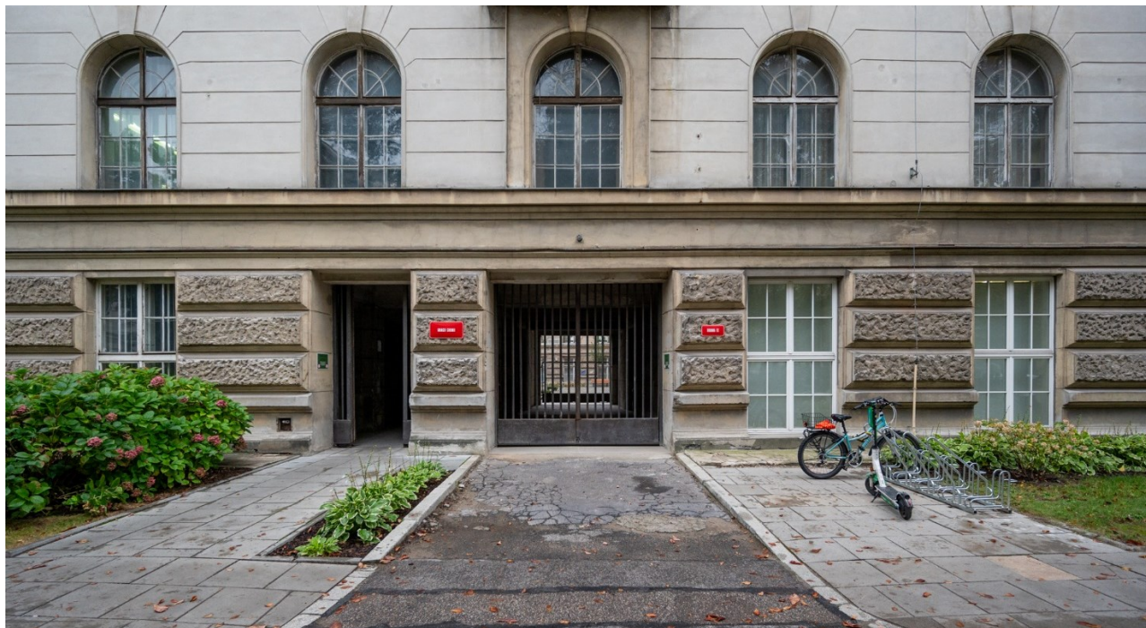
Zdjęcie 7 Wejście do budynku – od strony terenu wewnętrznego (dziejnińca) z bramą II
