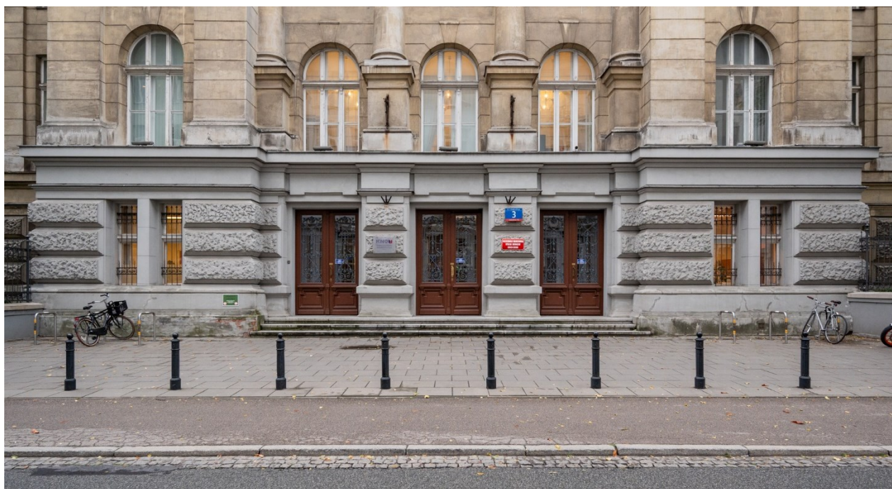
Zdjęcie 1 Widok na chodnik i wejście główne od ulicy Noakowskiego 3.
